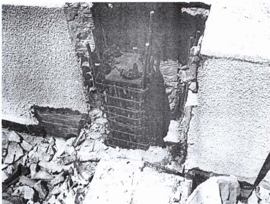
Photo 6.7 : Demi poteau servant de support à la structure du générateur photovoltaïque
