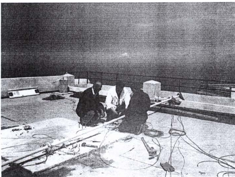
Photo 6.6 : Ici, opération servant à serrer les haubans avec les serre câbles
