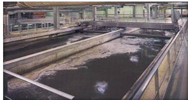
Figure II.5 : Dessableur-Dégraisseur Combiné rectangulaire
