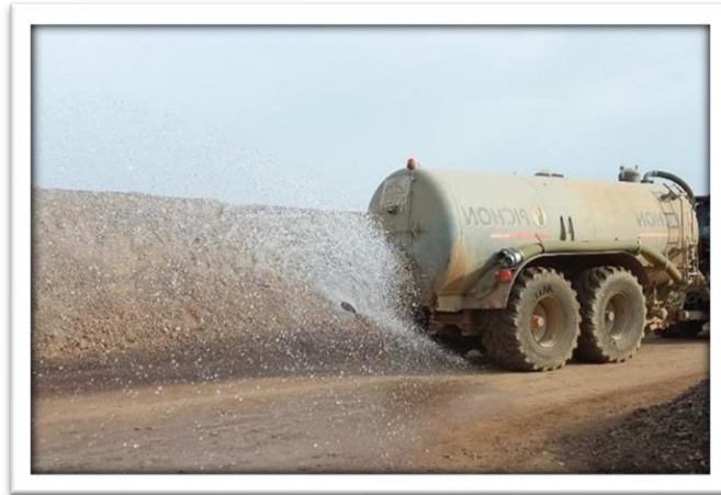
Figure 15 Arrosage d'une piste de circulation sur un chantier
