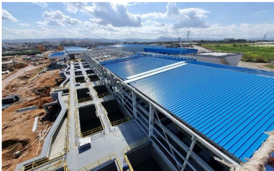
Figure 8 Vue générale du chantier de construction – Projet GCB
