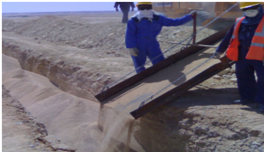
Figure VI.15: La mise en place du matériau de remblai tamisé
