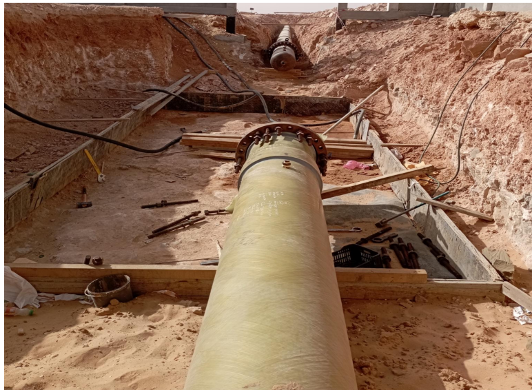
Figure VI.16: Préparation du test hydrostatique pour un tronçon de l'OH1
