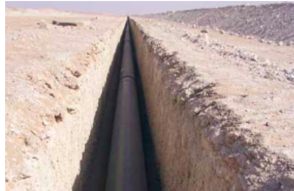
Figure VI.11: installation dans un sol stable
