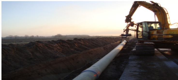
Figure VI.14: Descente du tuyau jusqu'à la tranchée à l'aide de la flèche latérale
