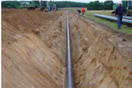
Figure VI.10 : installation dans un sol instable
