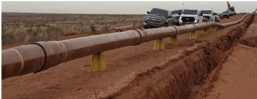
Figure VI.13 : Chaîne de pipeline prise en charge après l'adhésion
