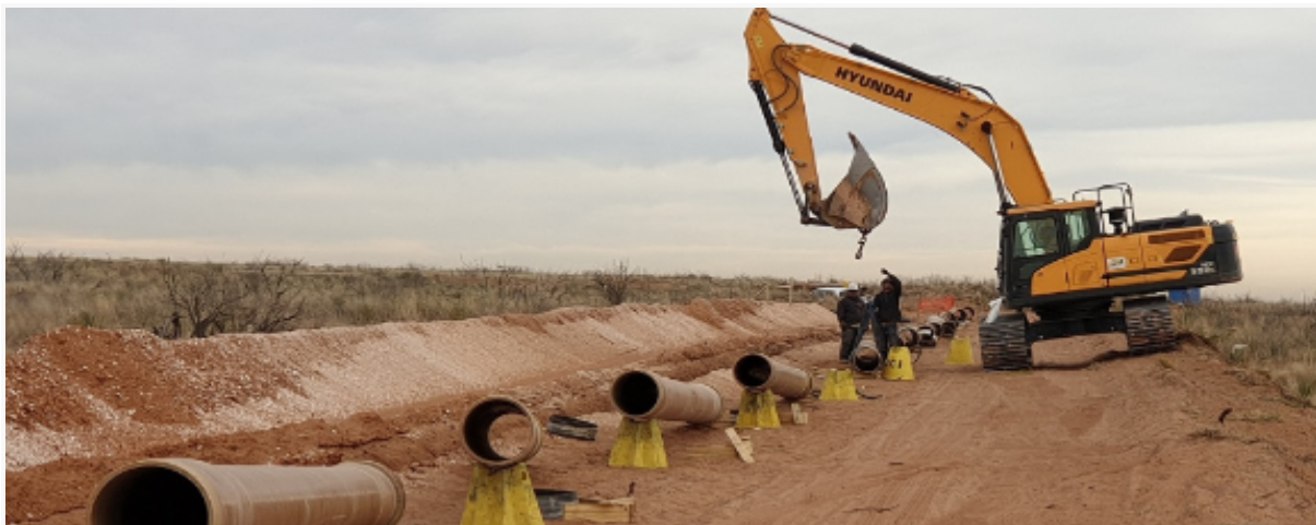
Figure VI.12: Enfilage de tuyaux le long du côté de la tranchée
