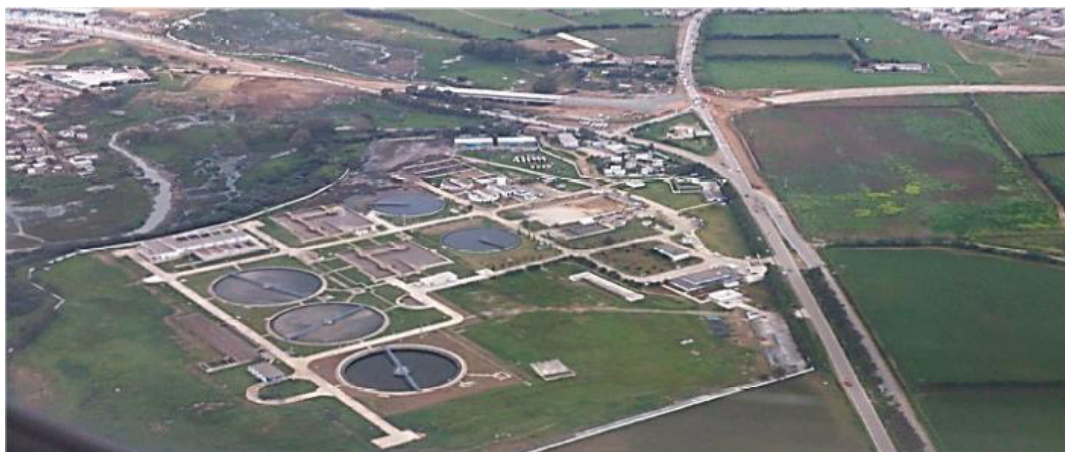
Figure N°8 : Vue générale de la station d'épuration de Réghaia.
