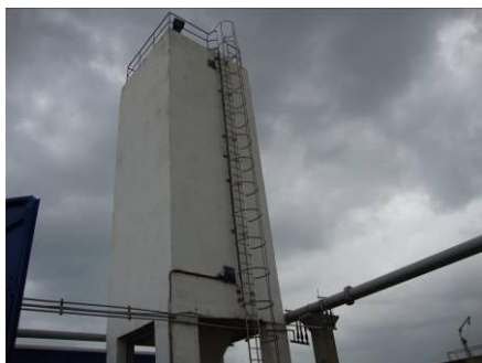
Figure N°16: Le Silo à chaux.
