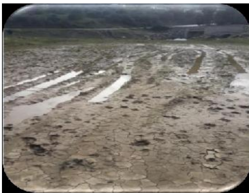
Figure I.1 : Envasement de barrage
