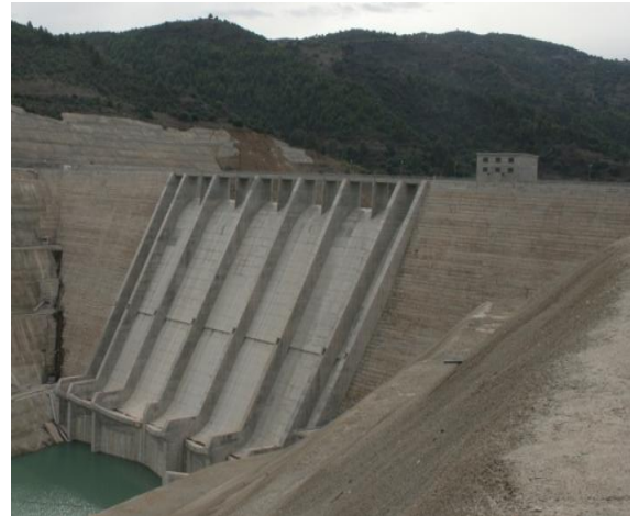
Figure I.10 : Corps de barrage
