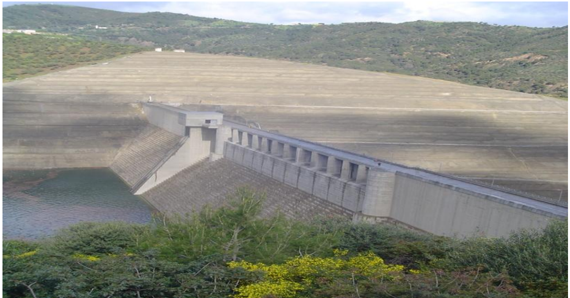
Figure I.8 : Barrage de KOUDIATE ACERDOUNE
