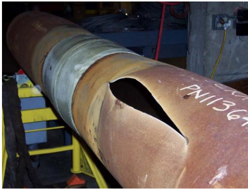
Figure 9. Rupture dans la section du matériau de base après un test d'éclatement [10].
