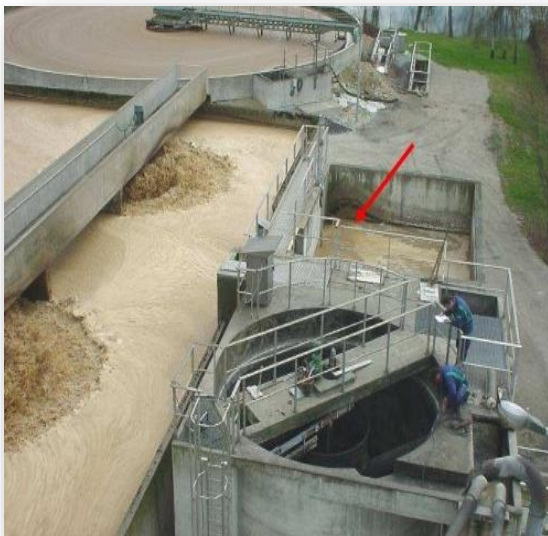
Figure V.39 : Zone de contact avant BA mélange intégral
