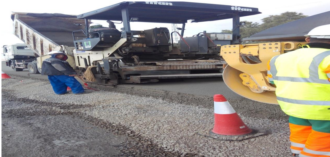
Figure I.4 : Mise en place du BCR en pavage par lafarge à Msila.
