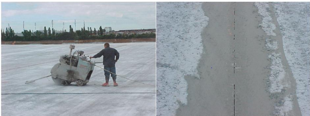
Figure 1.7 : Exécution de joints par sciage après mise en place du BCR - aire Industriel - montréal [25]
