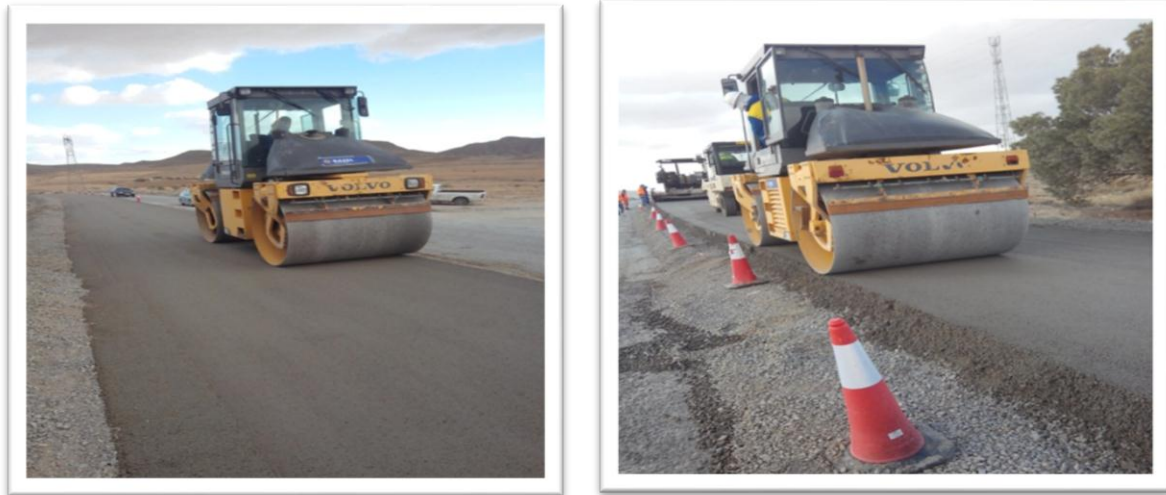
Figure I.3 : Compaction du BCR (projet de route de msila).
