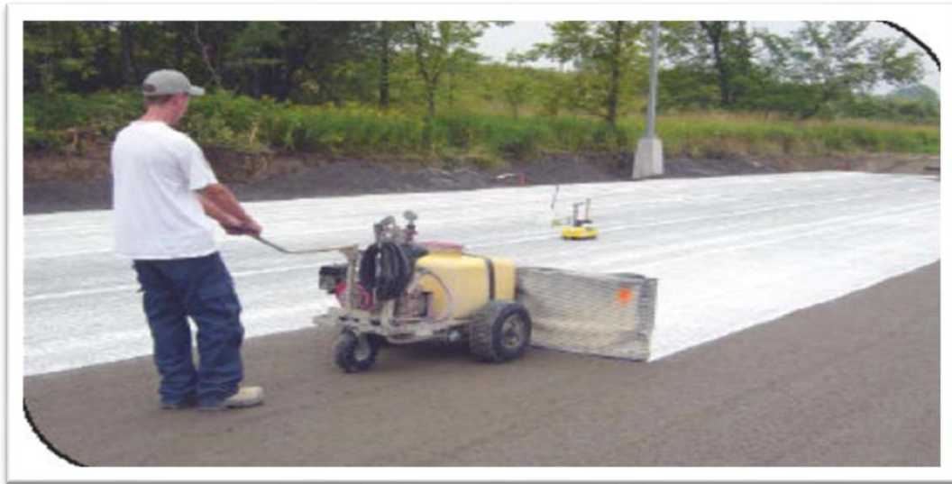
Figure 1.6 : Application d'un produit de cure après compactage du BCR - aire Industriel - montréal [17].
