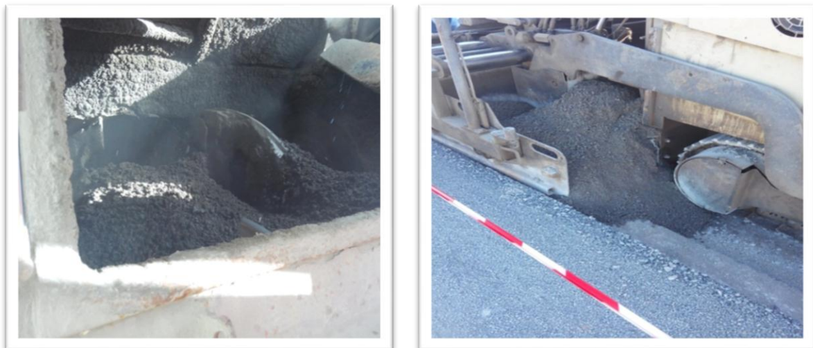
Figure I.2 : Etat du BCR frais lors de son déversement (Chantier de Msila).
