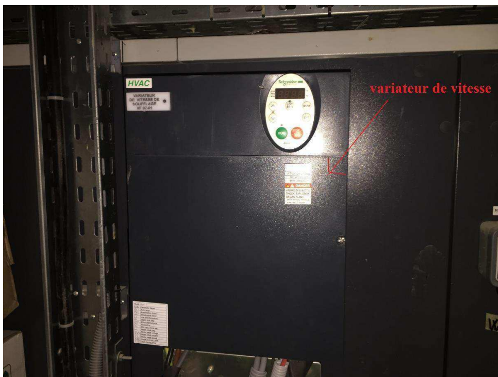
Figure II.7 : variateur de vitesse (CTA)
