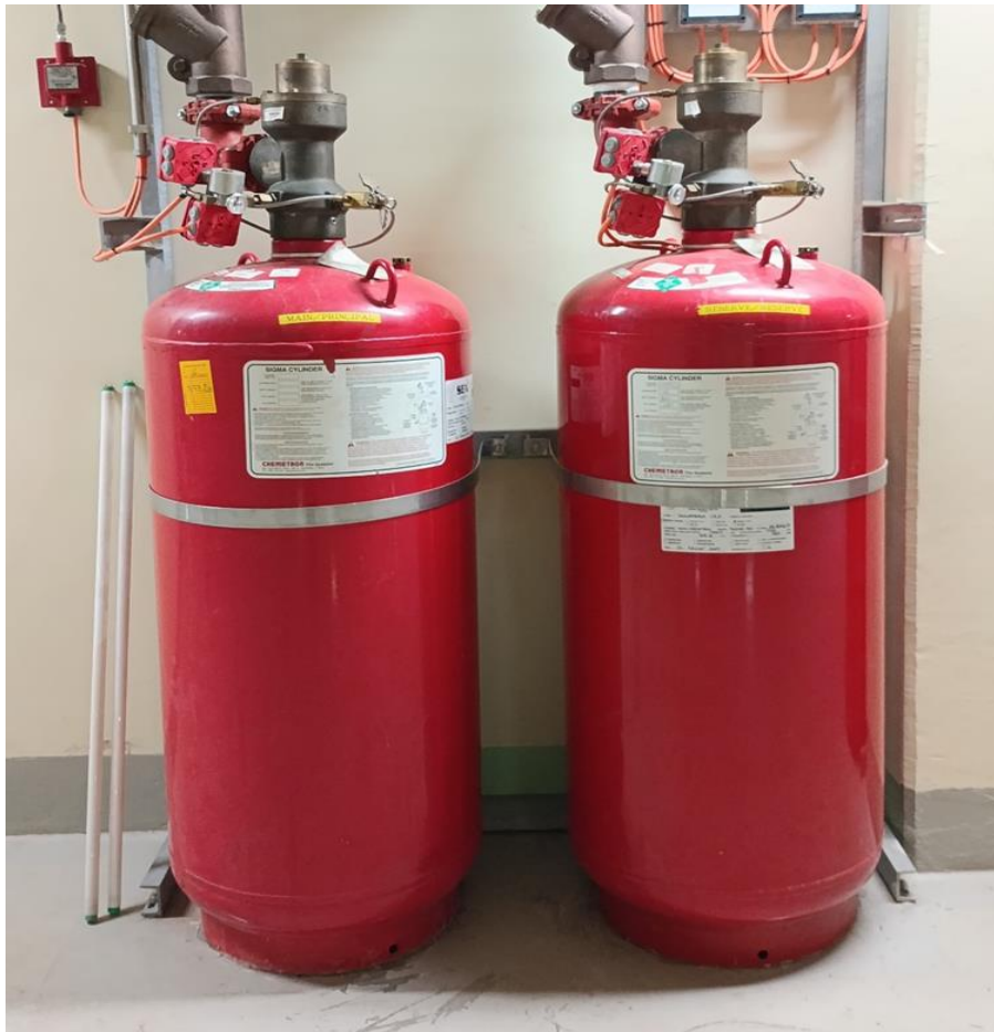
Figure II.7: Bouteilles d'agent extincteur SIGMA – Fluide Novec 1230
