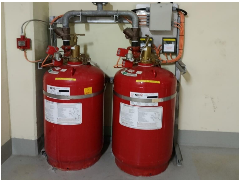
Figure II.6 : Bouteilles d'agent extincteur SIGMA – Fluide Novec 1230
