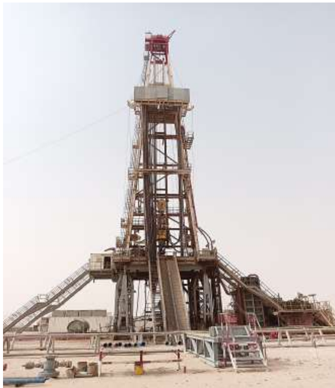
Figure I.2. Appareil de forage (ENF 61)
