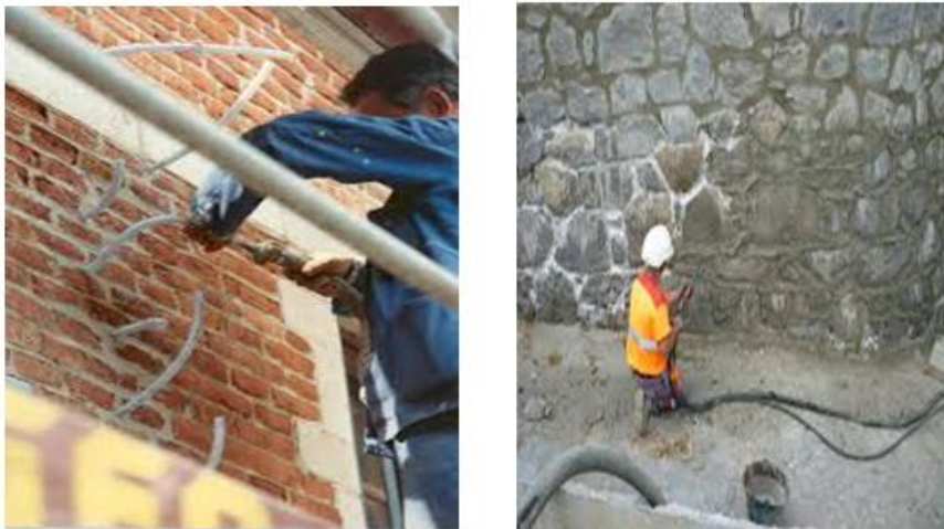
Figure II.1 Réparation des maçonneries de briques et de pierre par injection
