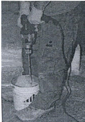
Figure 1.13 Préparation du mélange homogène de résine pour le collage des bandes de TFC
