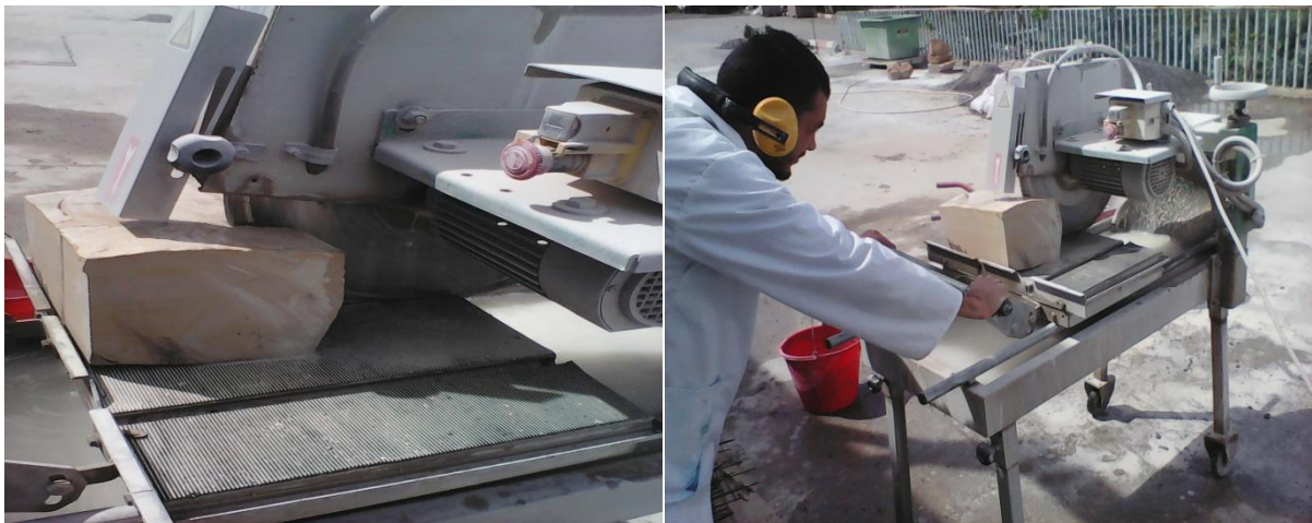
Figure III.22: coupures de la pierre à l'aide de la scie à béton
