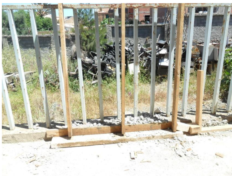
Figure III.26: dispositif pour la confection Des murets
