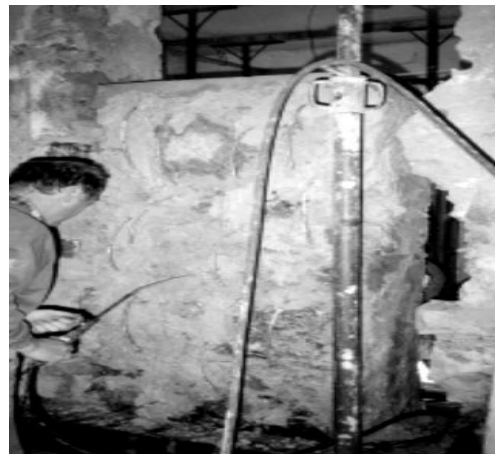
Figure II.20 Renforcement par l'ancien procédé d'injection
