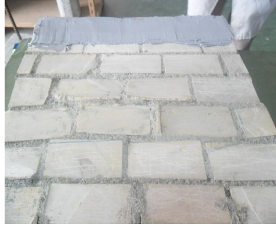
Figure III.33 : application de la résine
