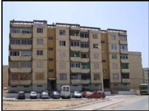
Fig. II.2: Cité des 800 logements Bâtiment R+4
