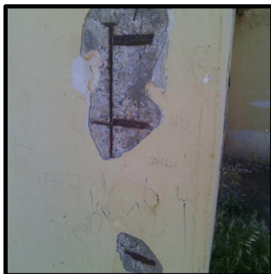
Fig.II.9: armatures de scellement corrodées, dommages non sismique
