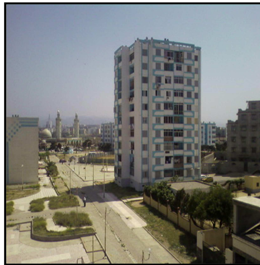
Fig. II.3: Cité des 800 logements Bâtiment R+9
