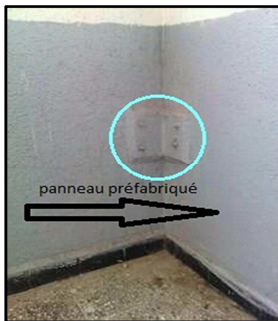
Fig.II.6: les panneaux préfabriqués retenus par des cornières
