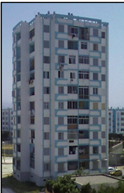
Figure.II.13 : le bâtiment ne présente aucun décrochement en élévation
