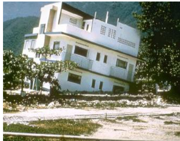
Fig. II.14. Liquéfaction des sols.
