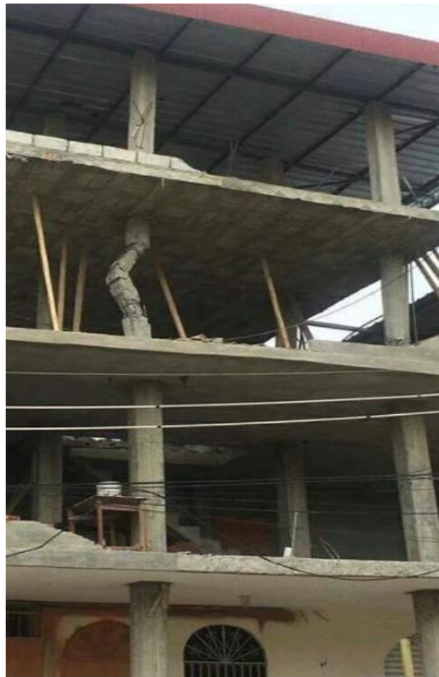
Fig. II.7. Flambement des poteaux.
