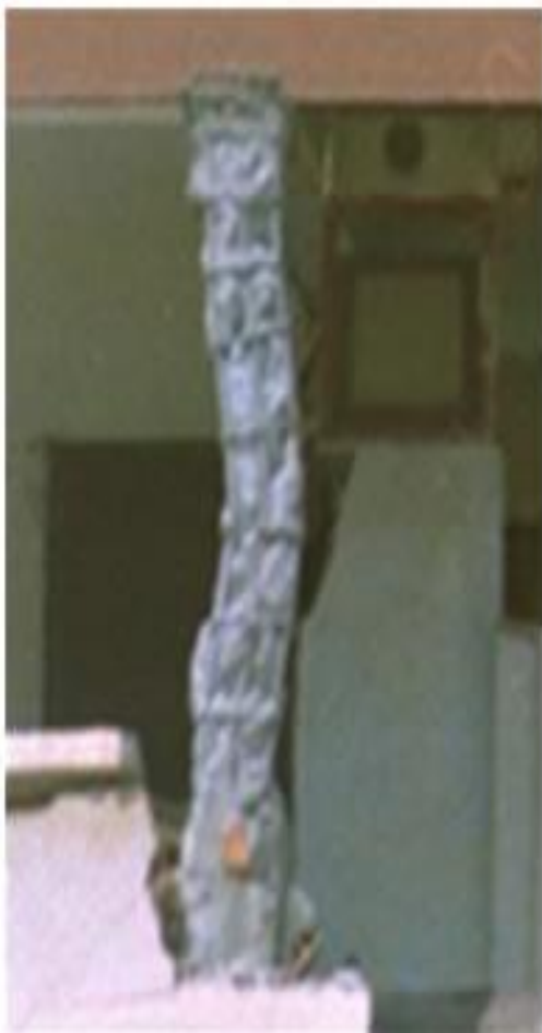
Fig. II.7. Flambement des poteaux.
