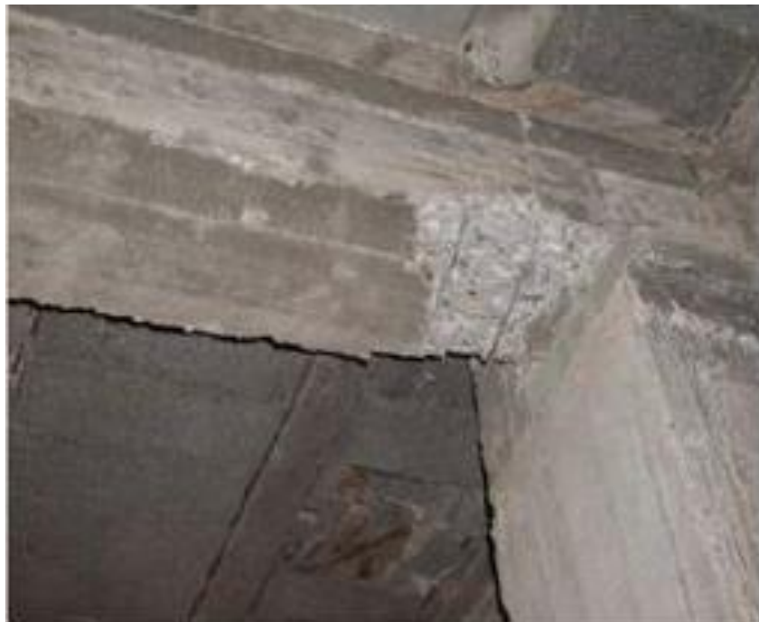
Fig. II.3. Critère « poteaux fortes – poutres faibles ».
