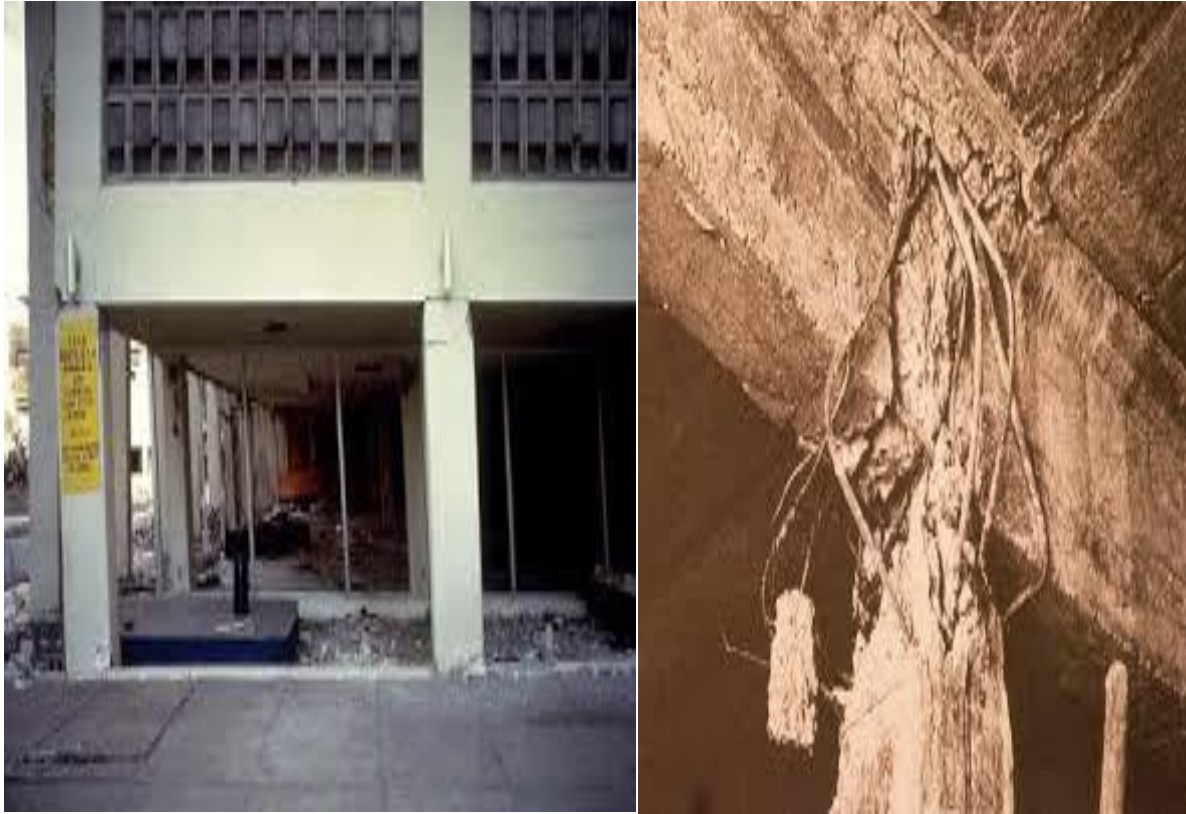
Fig. II.2. Critère « poutres fortes - poteaux faibles ».
