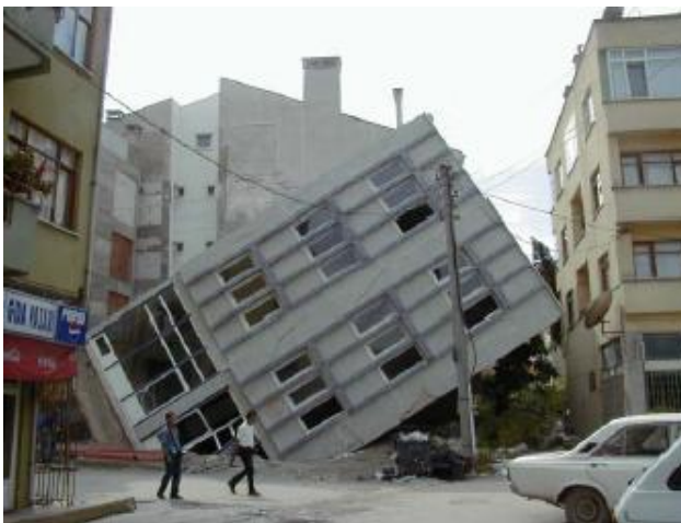
Fig. II.14. Liquéfaction des sols.
