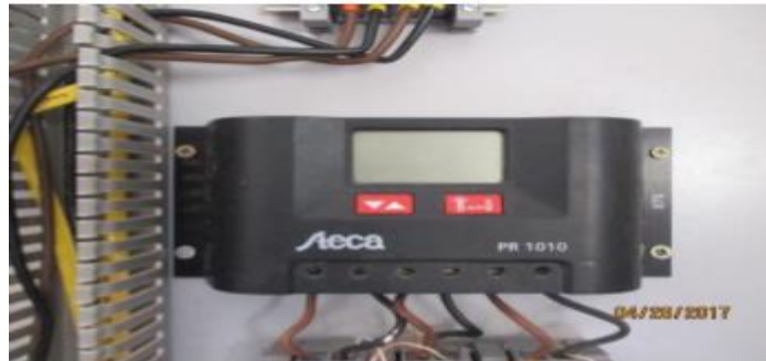
Figure I.29 : le régulateur de la charge
