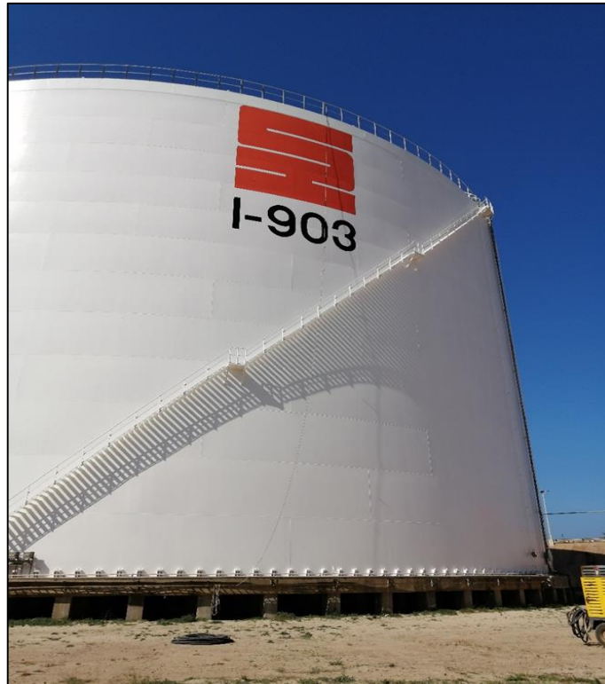
Figure VI.1 : Bac de stockage du GNL au niveau de complexe GL1/Z
