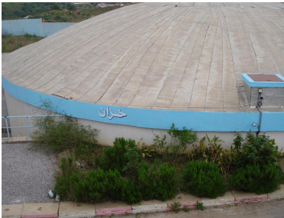
Photo 1.7: Bassin de stockage de l'eau.
