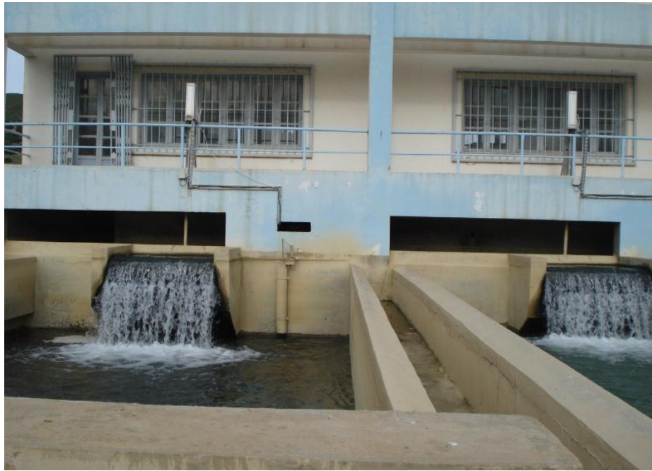
Photo 1.5: Bassin de filtration sur sable
