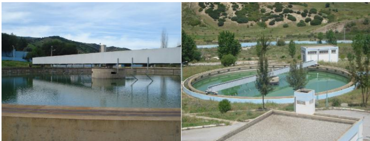
Photo 1.4: Bassin de décantation
