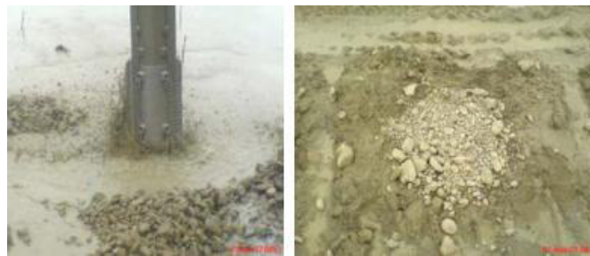
Figure .VI.7.Finition d'une colonne (site : barrage Kissir-Jijel)
