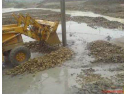
Figure.VI.6.Remplissage du trou par le ballast (site : barrage Kissir-Jijel).
