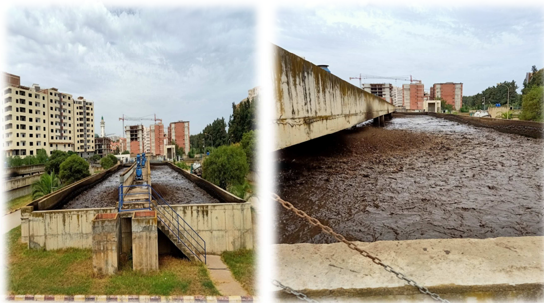
Figure III.6 : bassins d'aération
