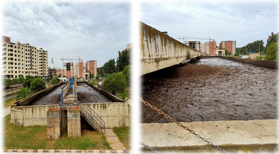
Figure III.6 : bassins d'aération
