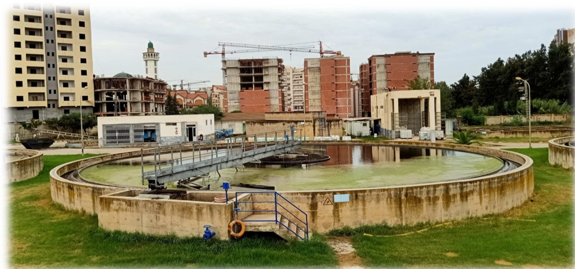
Figure III.7: décanteur secondaire – clarificateur
