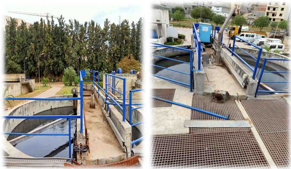
Figure III.5: Dessaleur - dégraisseur
