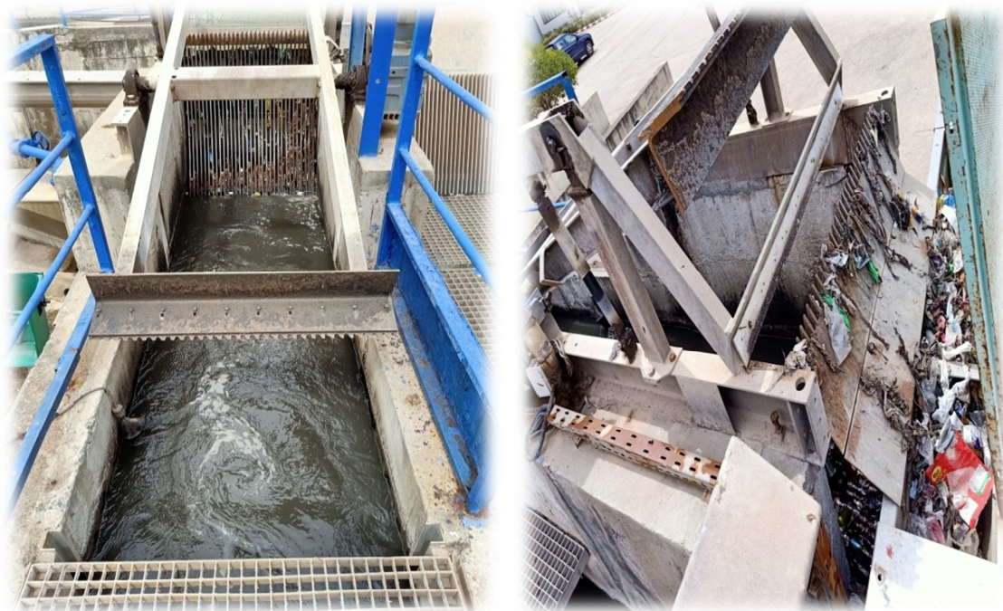
Figure III.4 : dégrilleur
