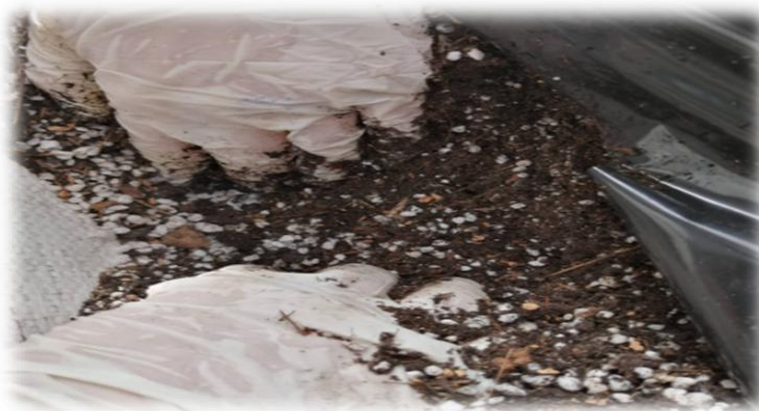
Figure 12 : Creusement avec un profondeur de 10-15 cm
