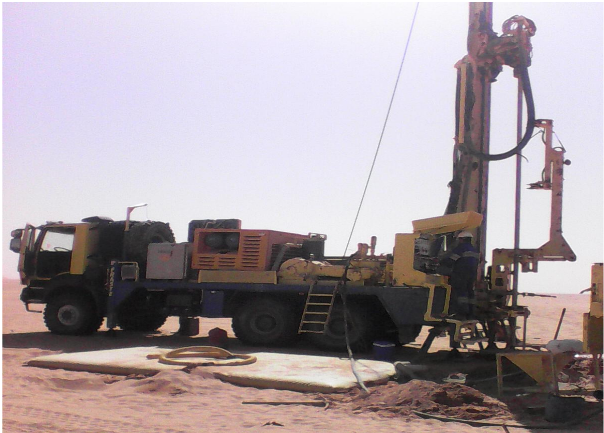
Fig II-11 : appareille de forage
