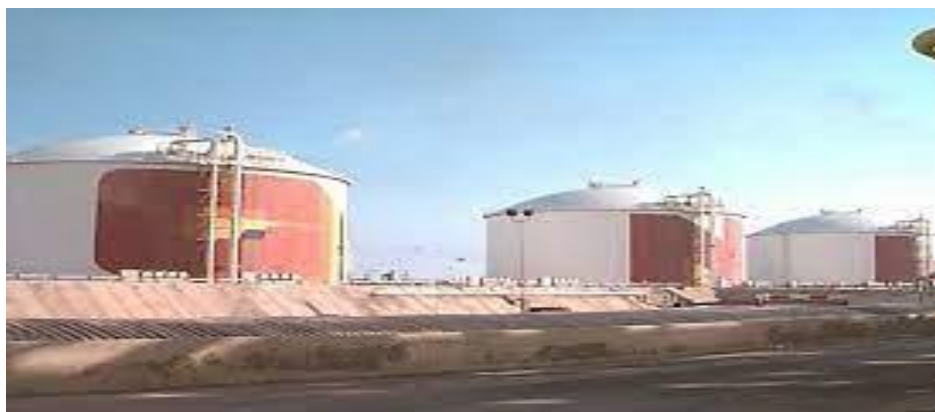
Figure I. 2: Les bacs de stockage du Complexe GL2Z
