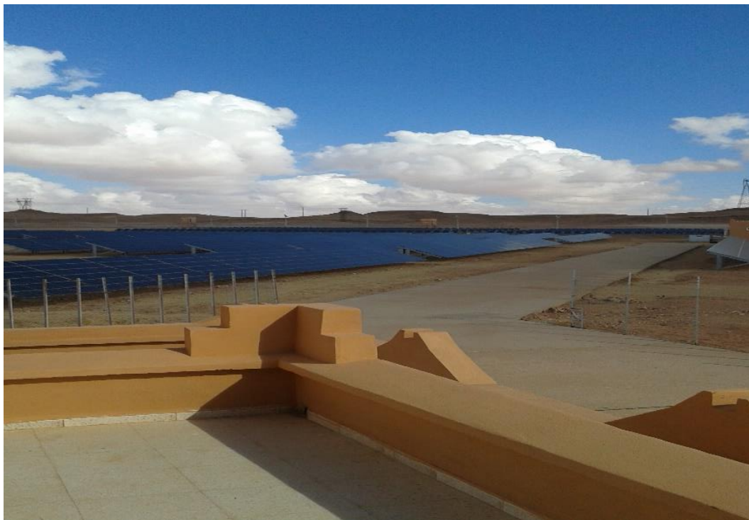
Figure I.13. Centrale pilote de 1.1 MW à Ghardaïa
