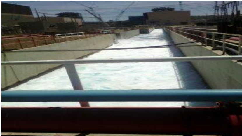
Figure 21: canal de rejet du la centrale
