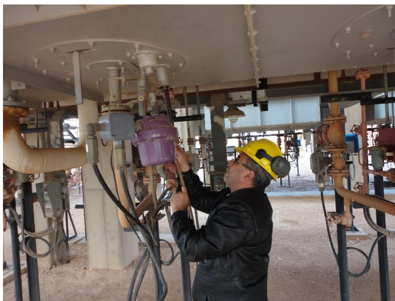
Figure II. 13 : Allumage du pilote avec torche.
