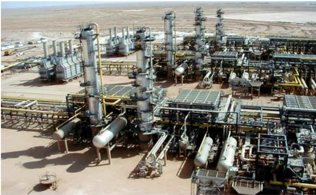
Figure I.1 : Vue générale sur le MPP IV
