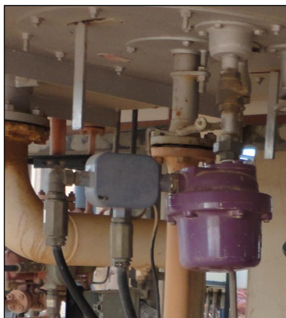
Figure II. 15 : Détecteur de flamme.
