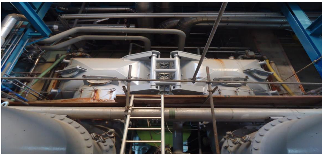
Figure I.2 : Le Condenseur.
