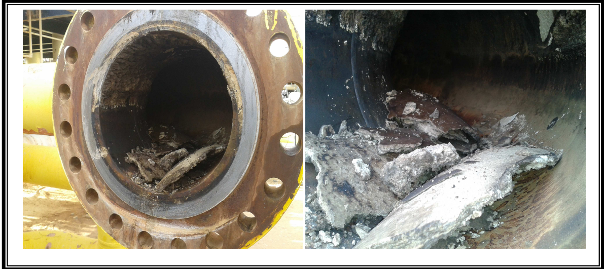
La conduite intermédiaire après le nettoyage chimique par l'acide acétique
