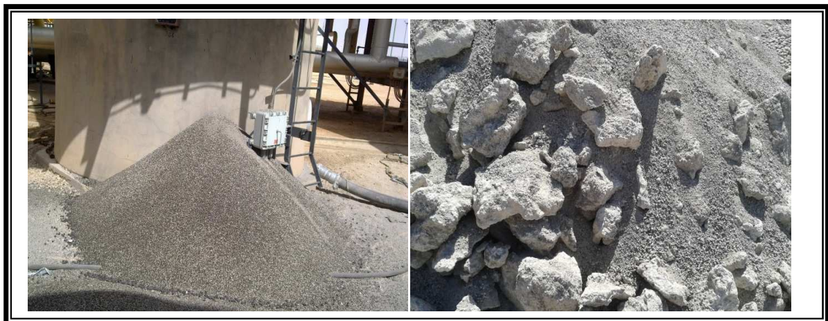
Figure 1.8: Tamis moléculaire lors de la vidange des sécheurs après 5 ans de fonctionnement
