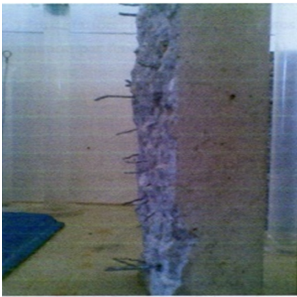
Figure 49 : Béton + 1.5% de fibres.
