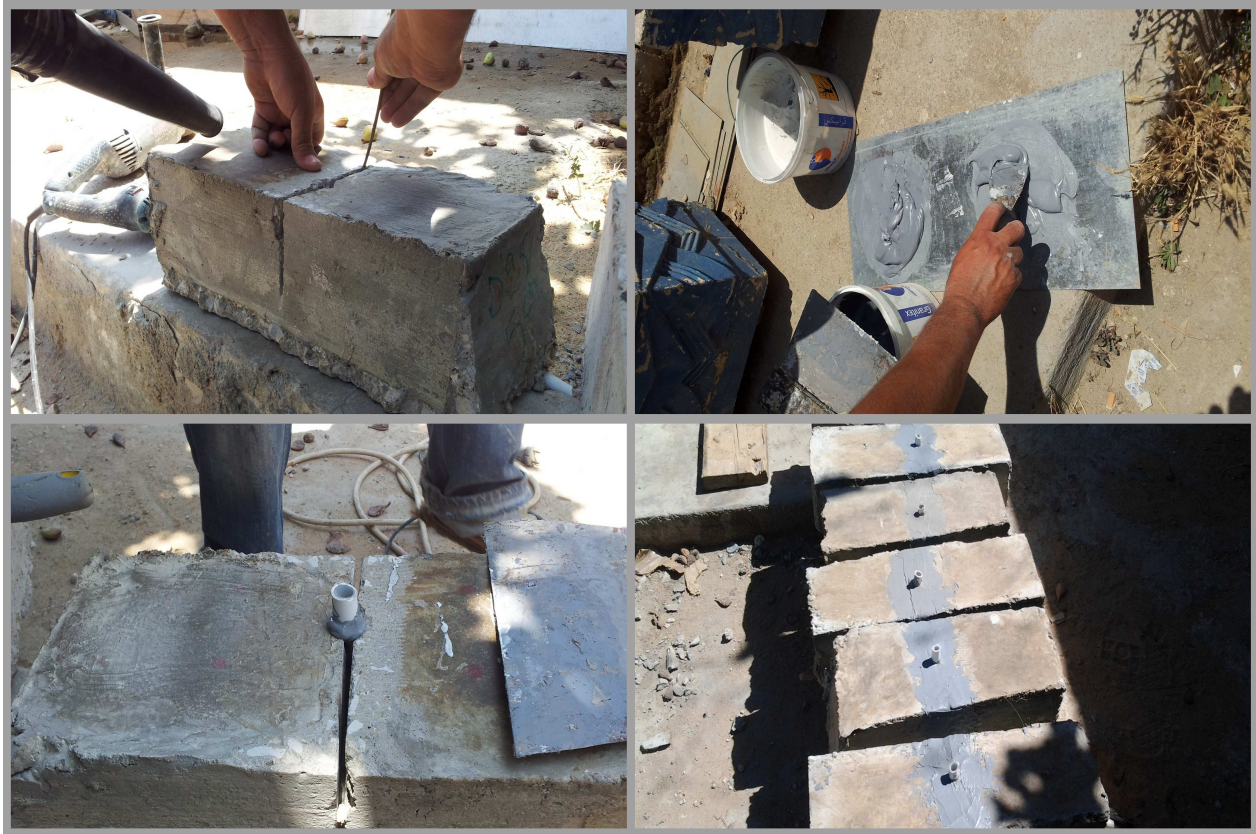
Figure-IV-9-Préparation des supports pour l'injection.
