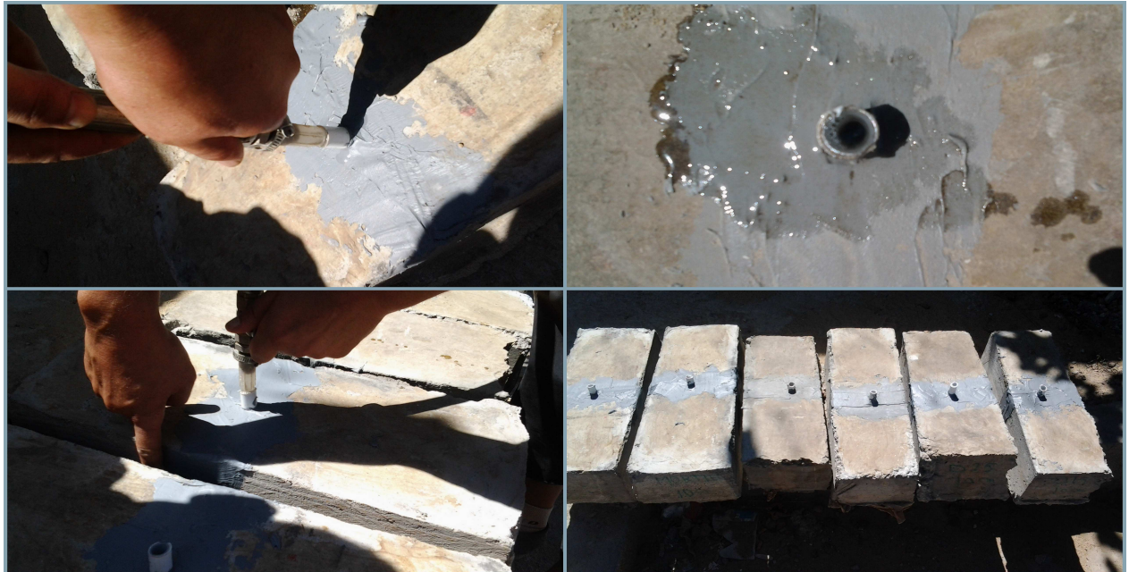
Figure-IV-10- Procédure de mise en œuvre de l'injection.
