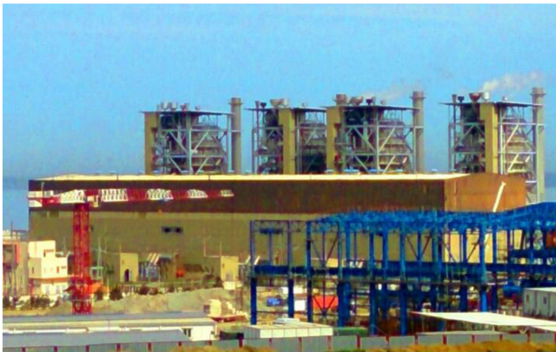
Figure I.1 : la centrale thermique de Ras Djinet
