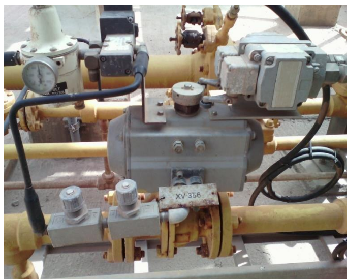
Figure 3.9 : Illustration d'une Electrovanne sur site
