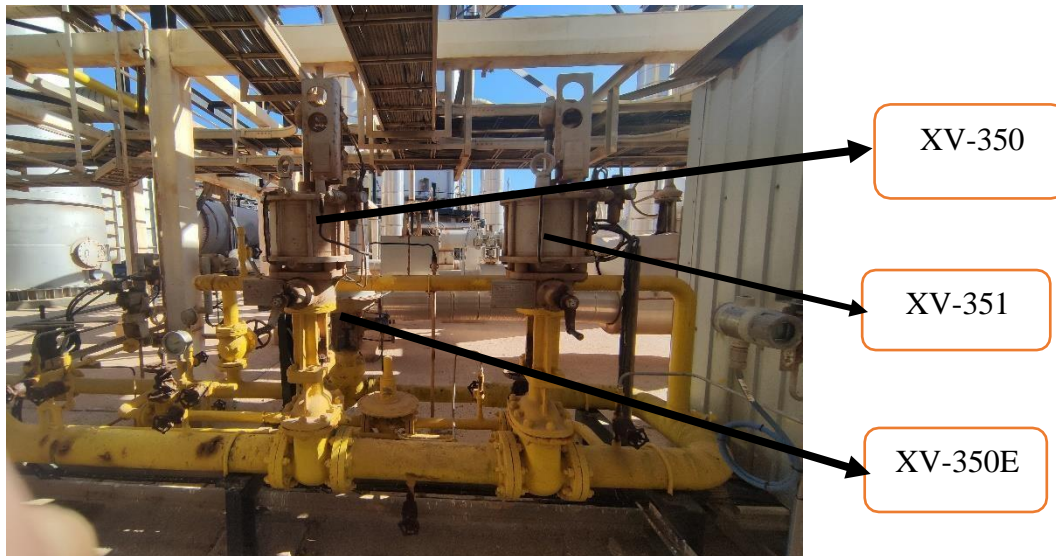
Figure 4.2 : Circuit brûleurs sur site
