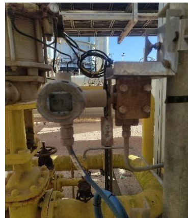
Figure 3.4 : Transmetteur de pression.
