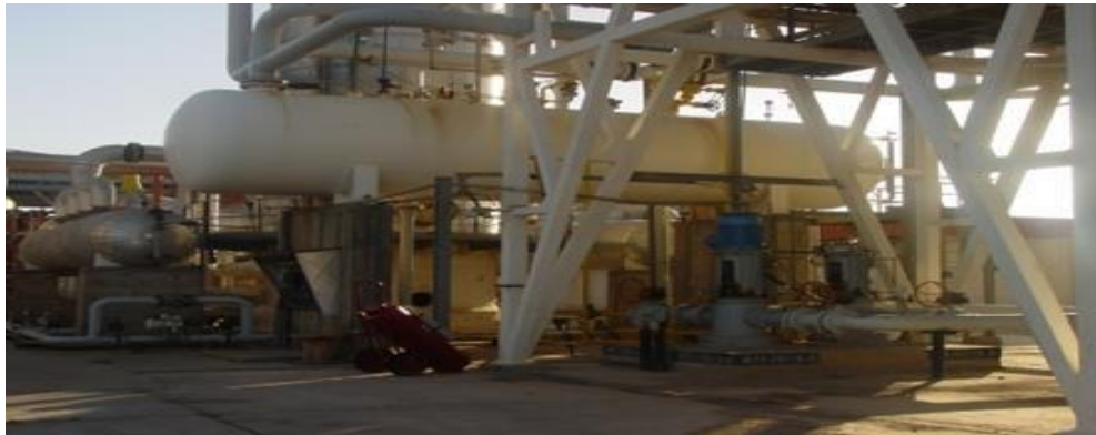
Figure 1.7 : Ballon de reflux sur site
