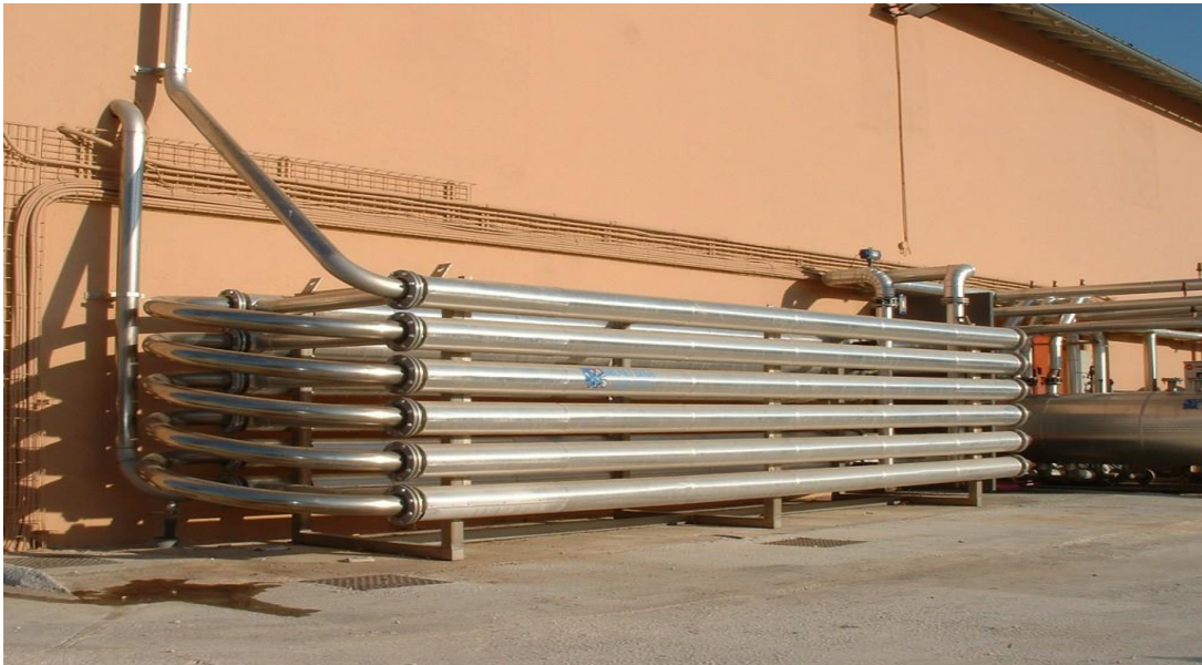
Figure 18 échangeur coaxial
