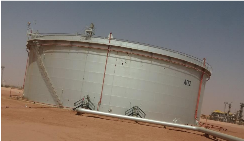
Figure 5: Réservoir à toit flottant (Bouguettaya, D., et al. , 2023)
