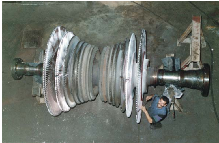
Photo 1 : rotor de la basse pression turbine à vapeur SCHNEIDER
