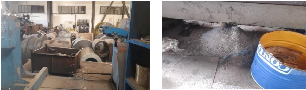
Figure 48 : exemple des anomalies observées dans la zone de travail
