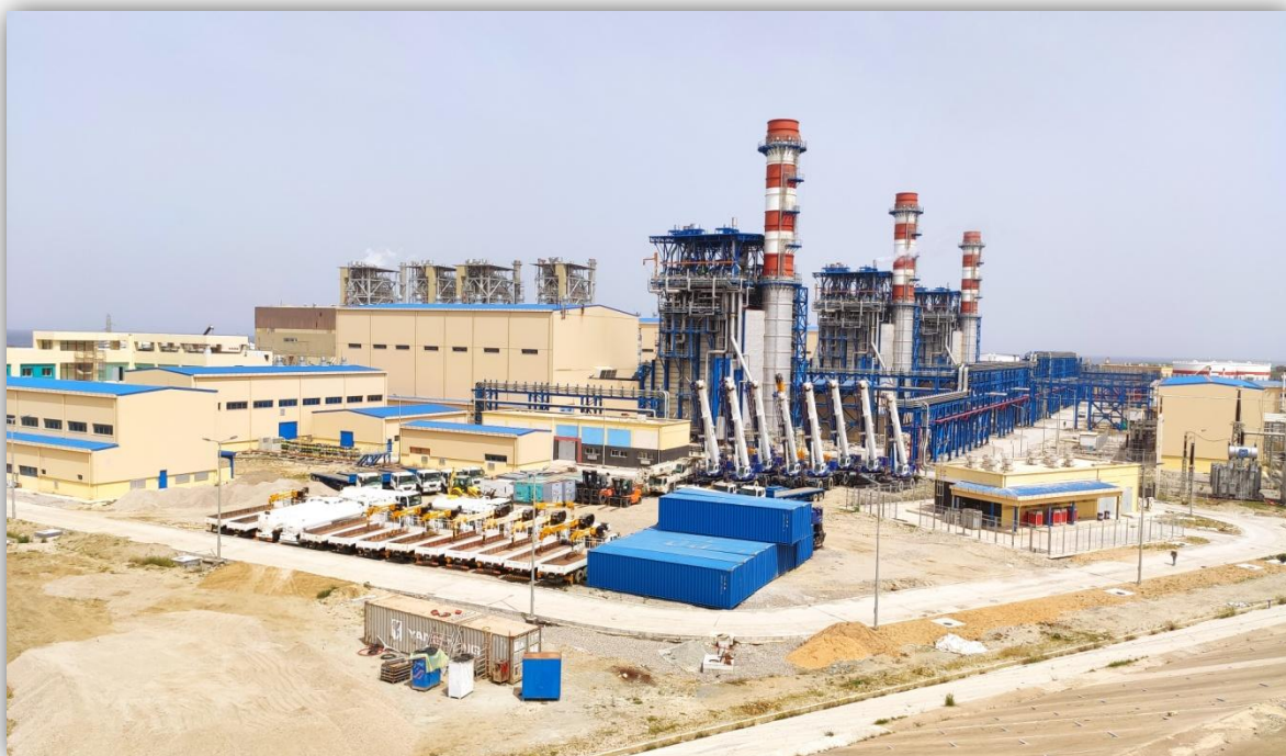
Figure II.4.1. Vue de la centrale Thermique de CAP-DJINET.
