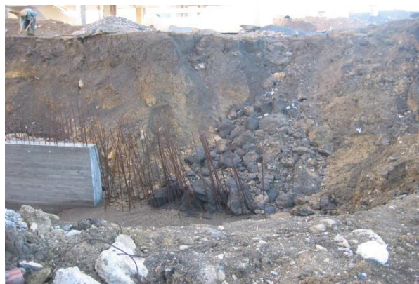
Figure IV-17: Eboulements des terres
