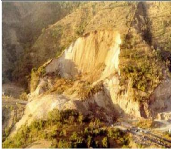
Figure I-28 : Glissement de Leona
