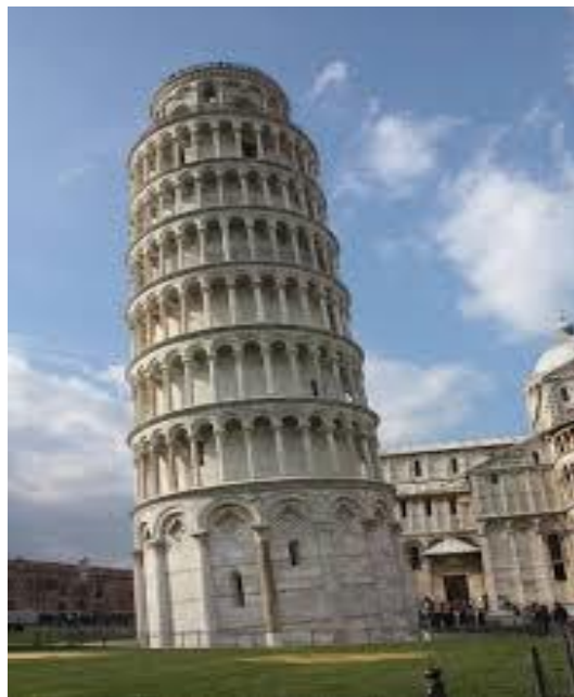
Figure I-5: Exemple de tassement différentiel en Italie
