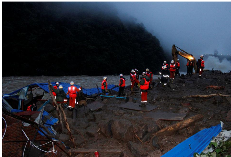
Figure I-27: Glissement de Chine
