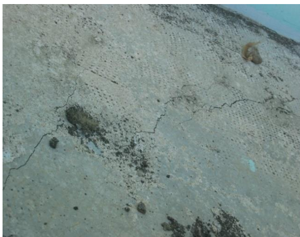
Figure IV-20: Fissures au niveau du revêtement sol et des planchers
