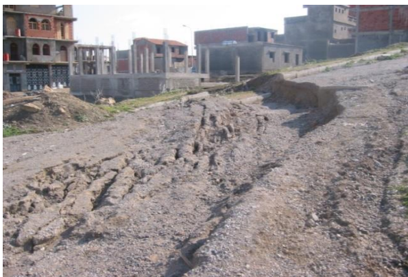
Figure IV-17: Eboulements des terres
