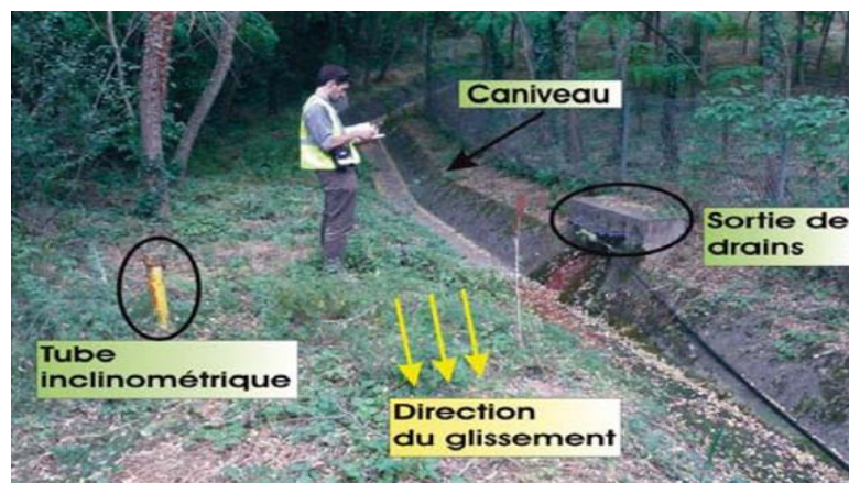
Figure III-7: Canalisation des eaux de surface
