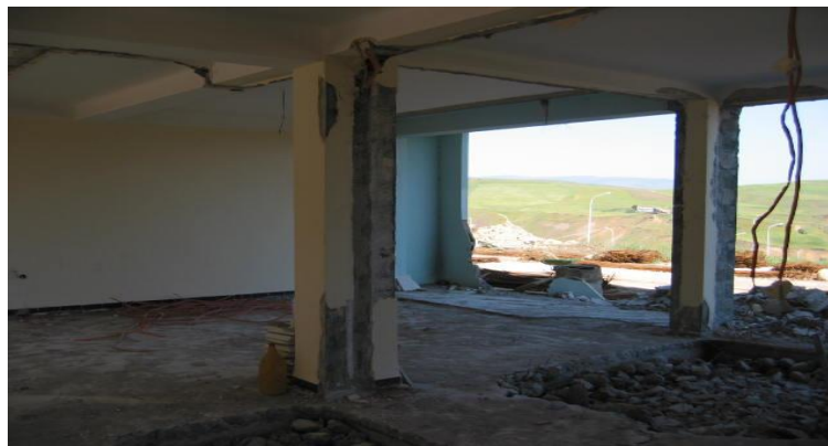
Figure IV-13: Endommagement des RDC dans deux blocs
