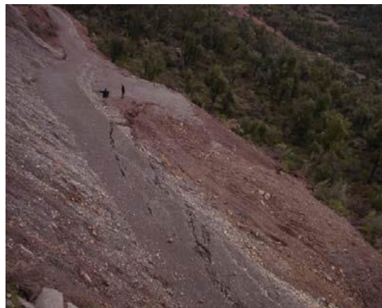
Figure I-23: Glissement de Bejaïa
