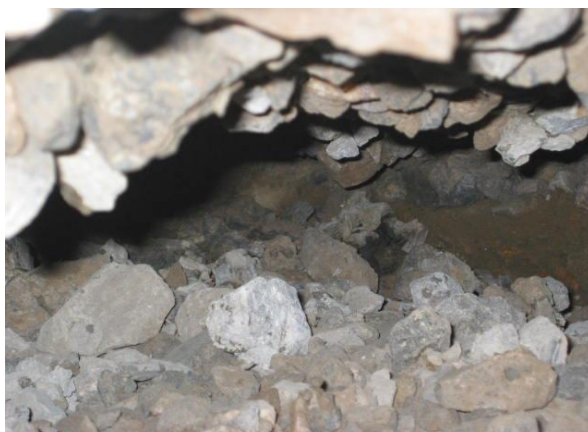
Figure IV-19: Tassement des remblais
