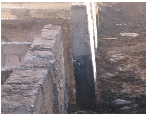
Figure IV-18: Les ouvertures des joints des murs de soutènement
