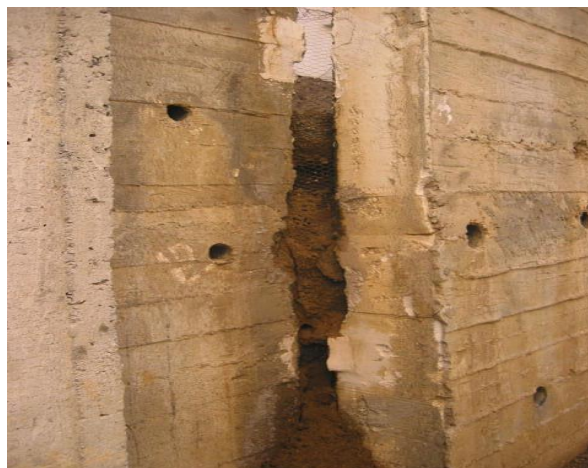
Figure IV-18: Les ouvertures des joints des murs de soutènement
