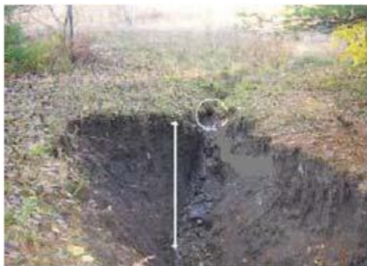
Concentration d'eau (ravinement)
