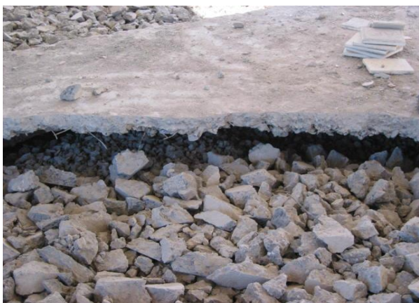
Figure IV-19: Tassement des remblais
