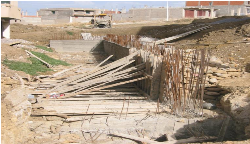
Figure VI-7: Réalisation des murs de soutènement
