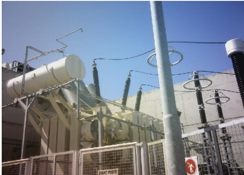
Figure IV.5 les points de connexion HT du groupe N°2.
