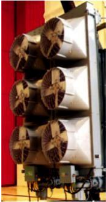
Figure II.6 aéroréfrigérants.
