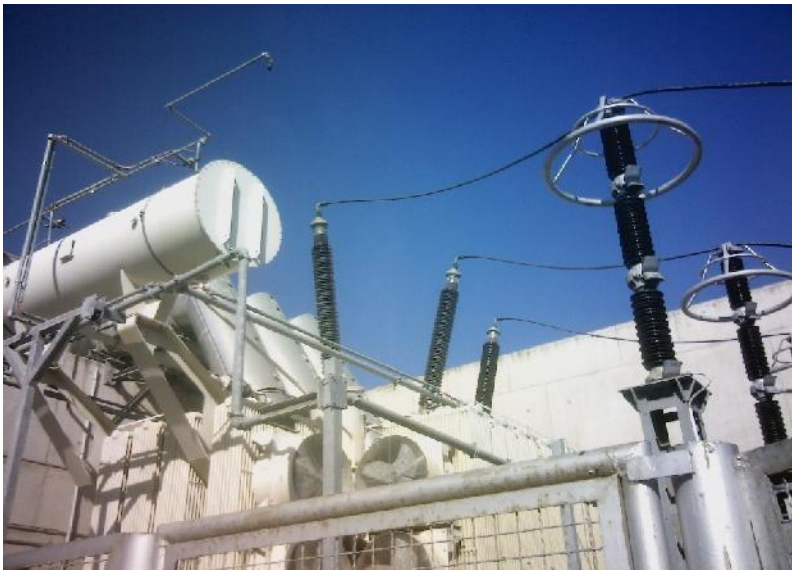
Figure IV.11 les points de connexion HT du groupe N°3.
