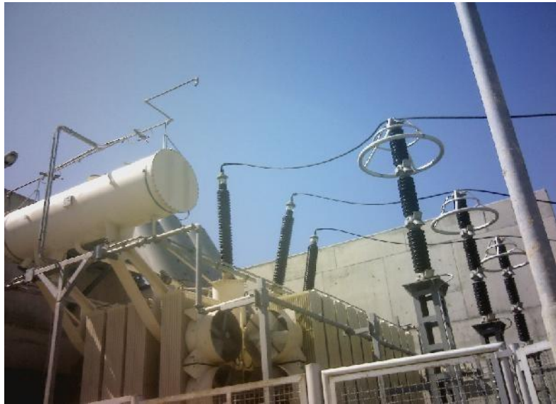
Figure IV.17 les points de connexion HT du groupe N°4.
