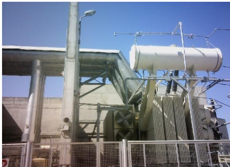
Figure IV.16 les gaines coaxiales MT du groupe N°4.
