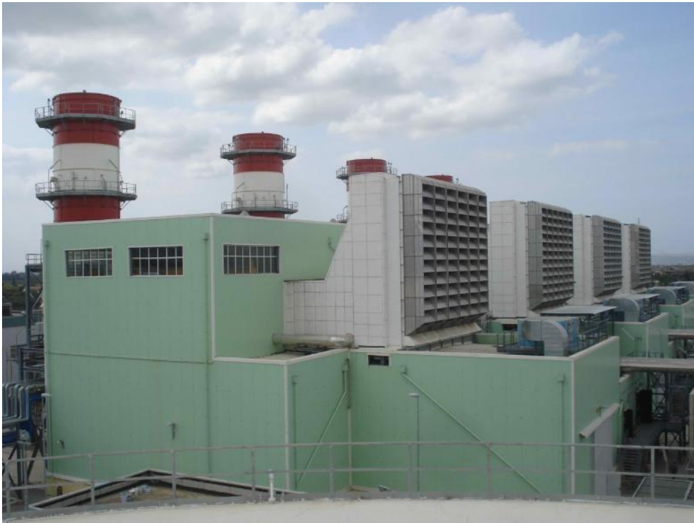
Figure I.1 la centrale électrique LARBAA
