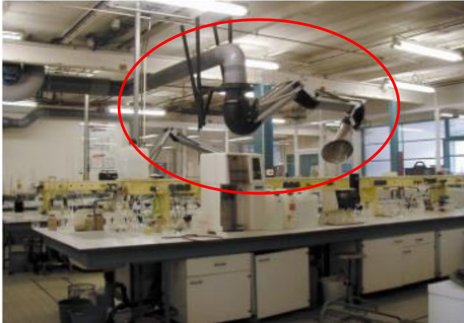
Figure 12 : représente une paillasse avec un bras de type captage à la source. (18)
