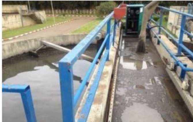
Figure 3.6 : Dégraisseur-dessableur.
