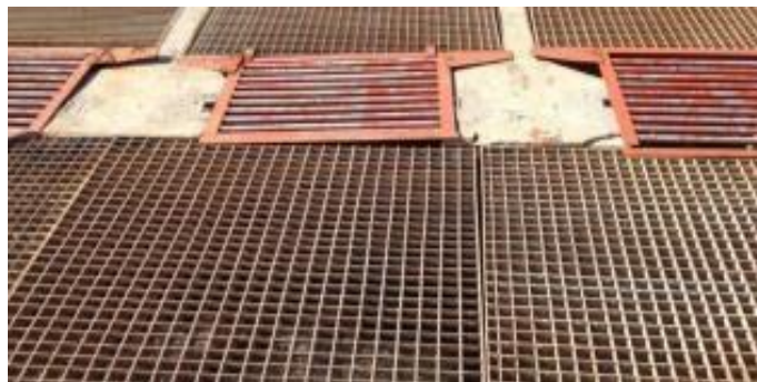
Figure 3.7 : Ouvrage de répartition
