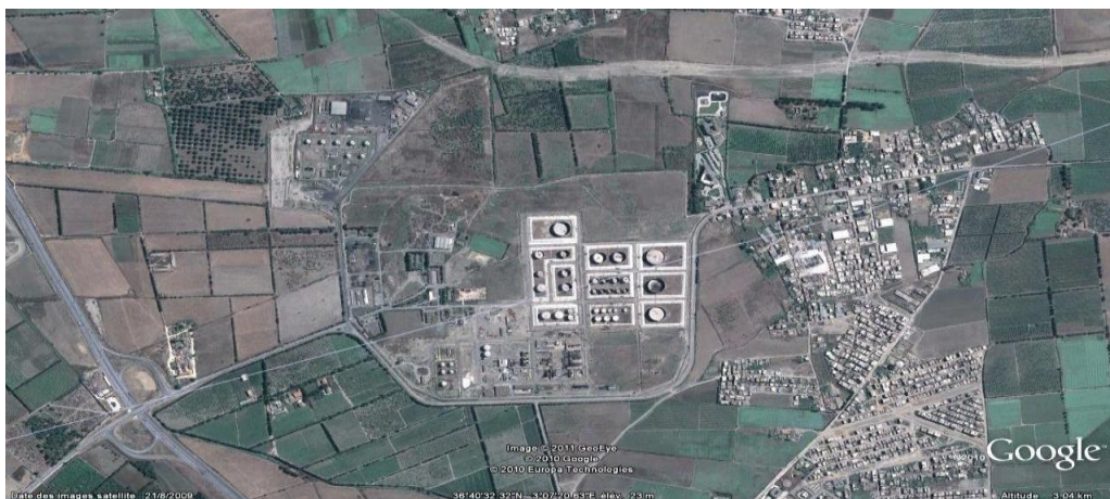
Figure I.1: Vue aérienne avec Google Earth présentant l'emplacement de la raffinerie d'Alger
