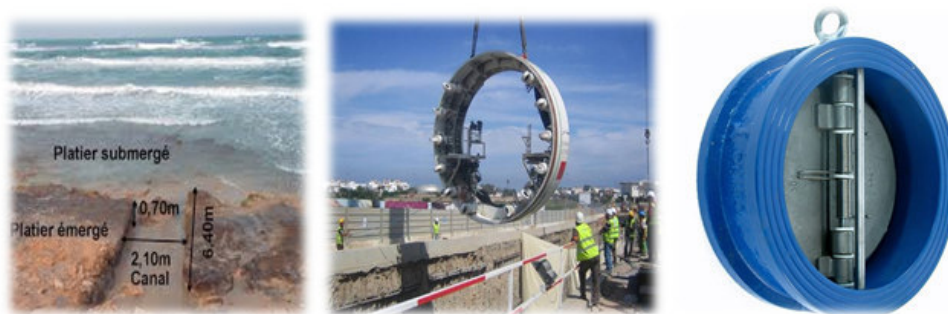
Figure 5.30. La mise en place d'un canal équipée d'un clapet.
