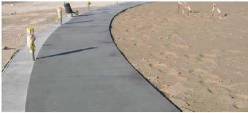
Fig.III.8: Pose des tôles marginales
