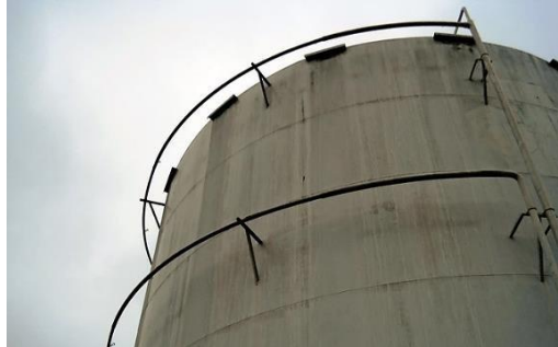
Fig.X.7 : Couronne de refroidissement
