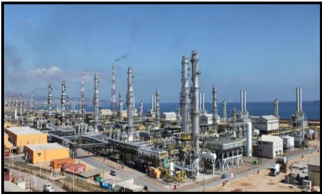
Figure I. 1 Les Trains dans Complexe GPL
