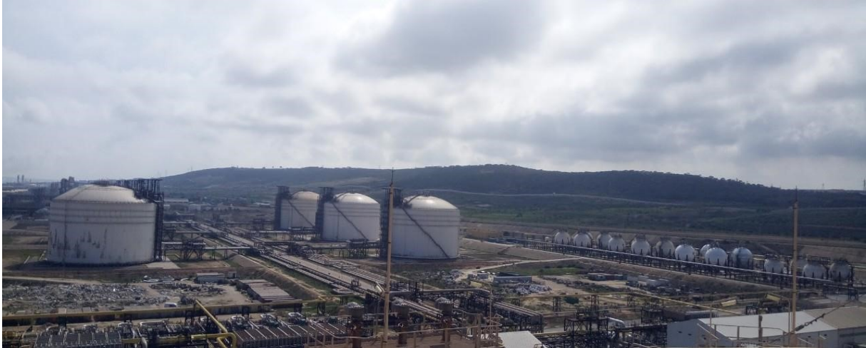
Figure I. 3: Vue générale des bacs de stockage
