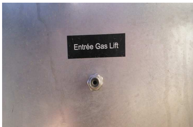
Figure 6.17 : Entré et Sortie de raccordement du Skid d'injection.
