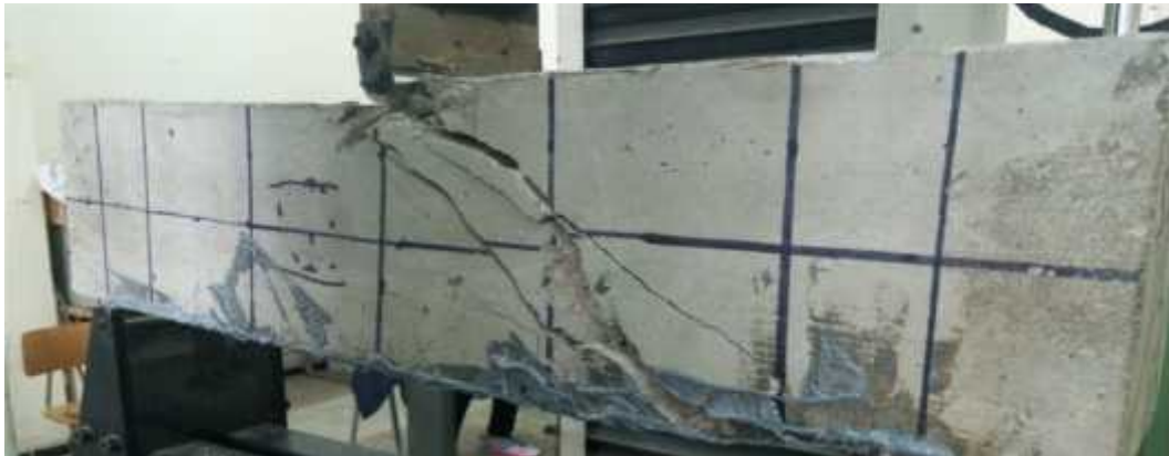
Figure II.24 : rupture de poutre (PIC) par cisaillement
