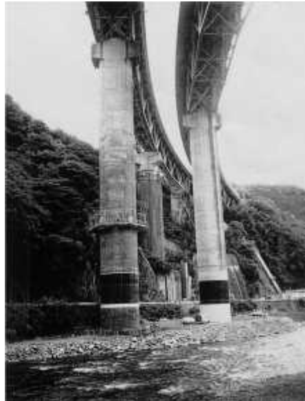
Figure I.14 : Sakawagan Bridge au Japon (8 piles de 42 à 65 de hauteur et de 7 m de diamètre) : passerelle de mise en œuvre de la fibre de carbone[23]
