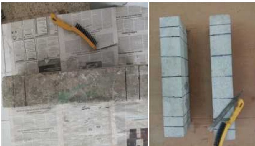
Figure II.17 : la préparation de la surface de la poutre
