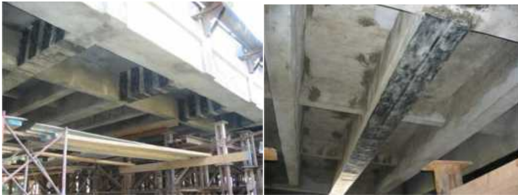
Figure I.16 : Réparation et renforcement des poutres de pont par matériaux composites [13]
