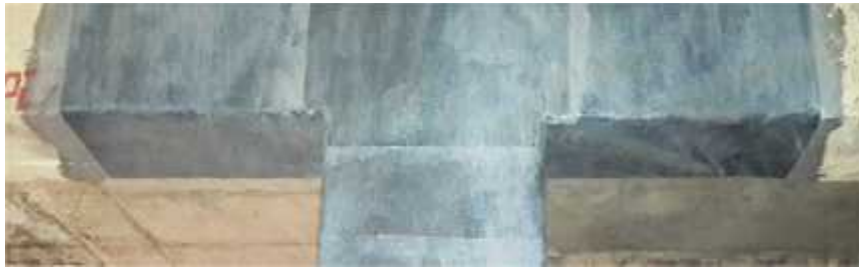
Figure I.18 : Application de composite sur les poutres d'hôtel [24].
