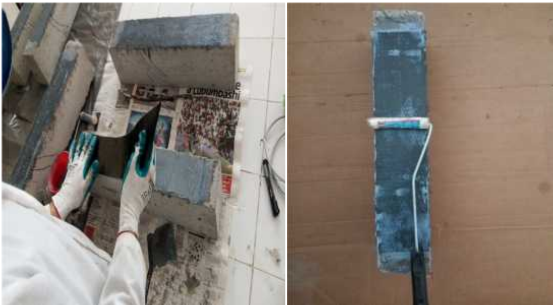
Figure II.20: l'emplacement de tissu SikaWrap HEX 230 C sur la poutre
