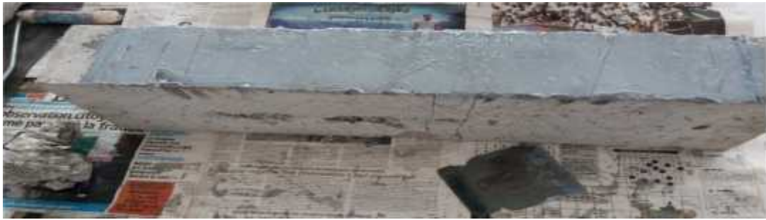
Figure II.19: application de la première couche de colle sur la poutre
