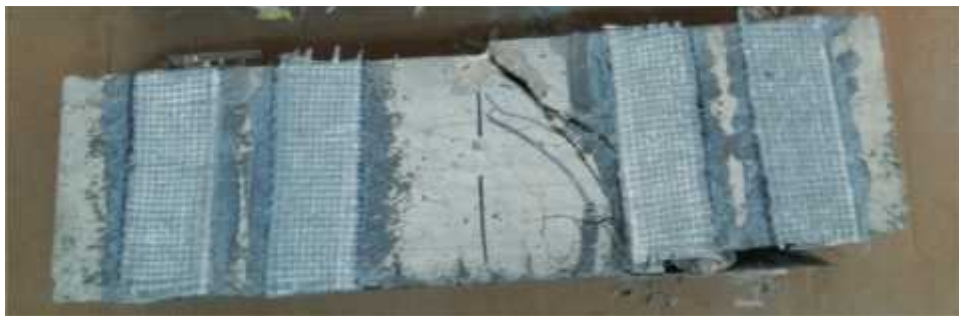
Figure II.36 : Poutre P2CVD décollement du bande GFRP puis rupture par cisaillement
