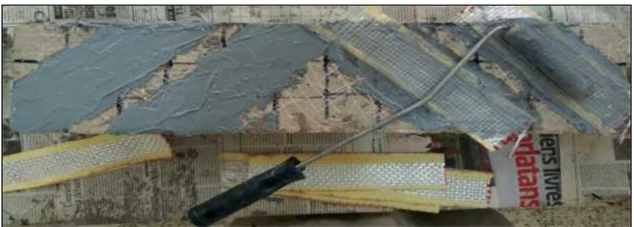
Figure II.22 : application de fibre de verre ® sur la poutre
