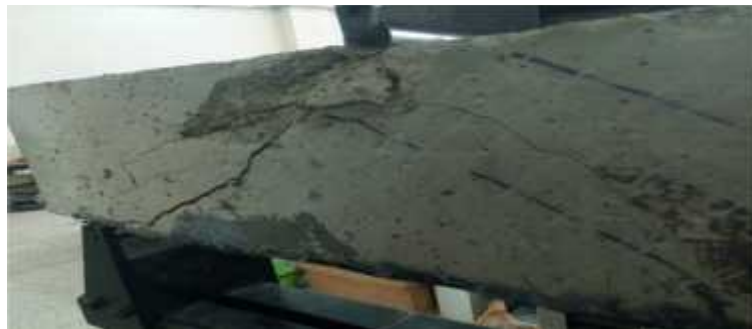
Figure II.33 : poutre (P2C) compression de béton, délaminage de la bonde et rupture par cisaillement
