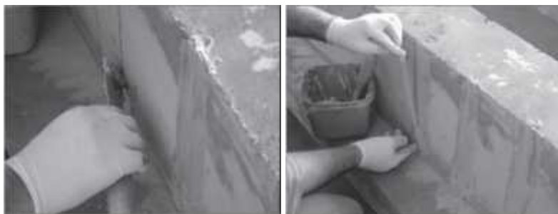
Figure I.9 : Technique de renforcement par la méthode NSM [5]
