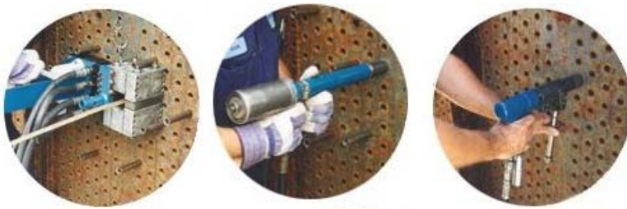
Figure III.8 : nettoyage a l'aide d'un pistolet hydraulique
