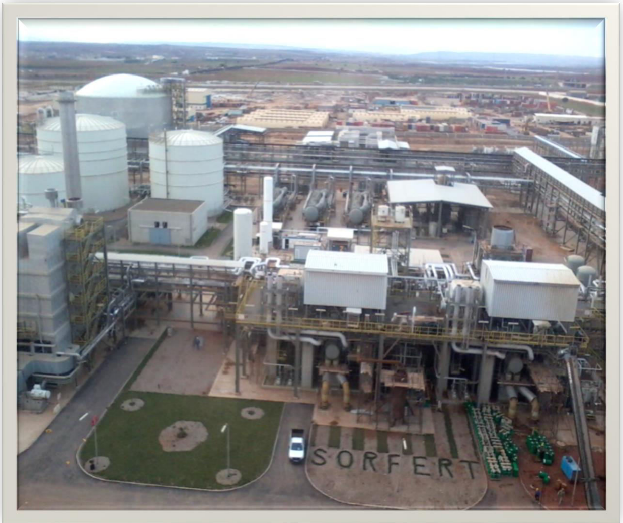
Figure I.3: Vue du haut de la zone des utilités
