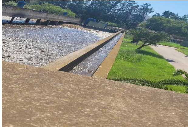
Figure I-7 : Bassin d'aération.
